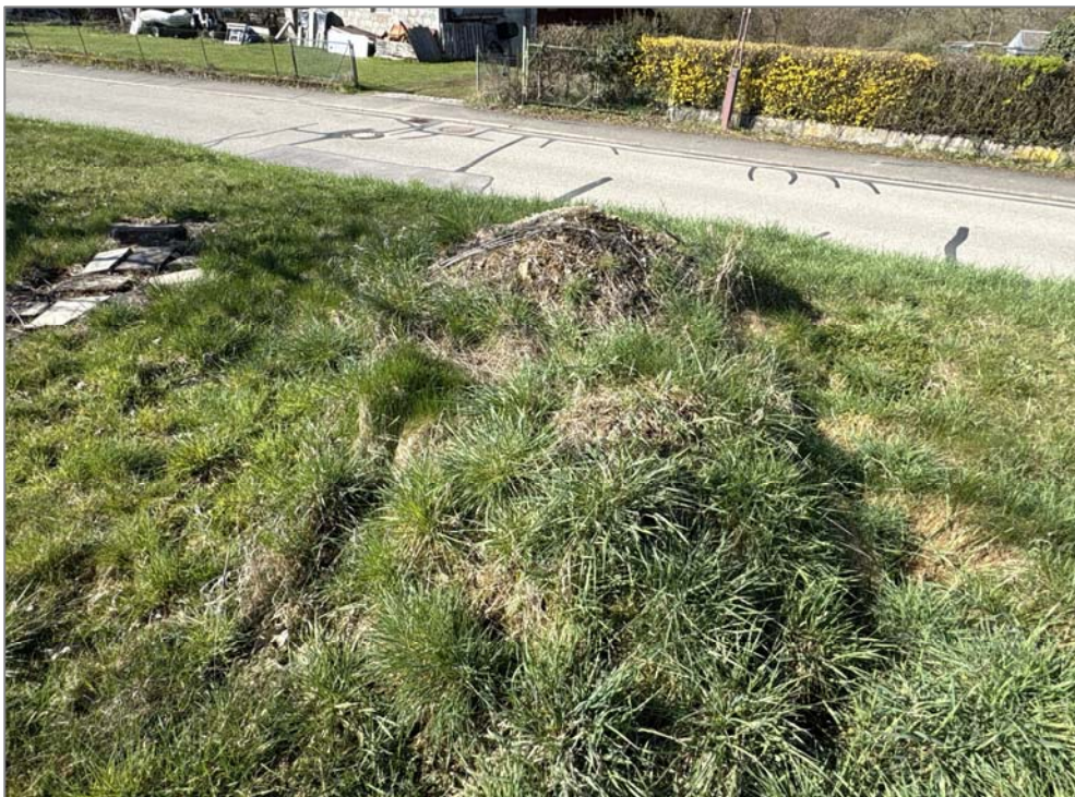
Abb. 6: Schutthaufen und mit Platten abgedeckter Schacht (Foto: HPC AG, 12.03.2026)
